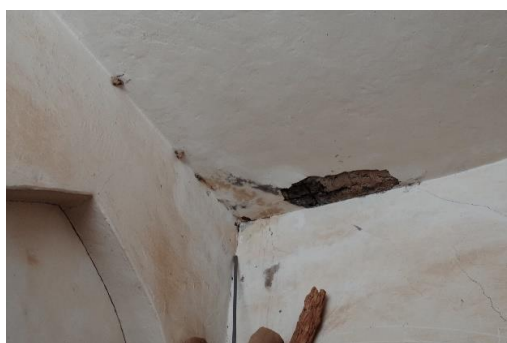
تصدعات الخرسانة المسلحة المستحدثة في سقف الجامع
